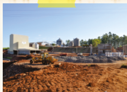
Fábrica Nutri A1 em construção, em meados de 2013
